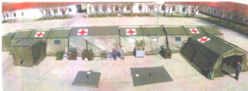
Каркасно-тентовая палатка с наружным каркасом и солнцезащитным тентом (Турция).
